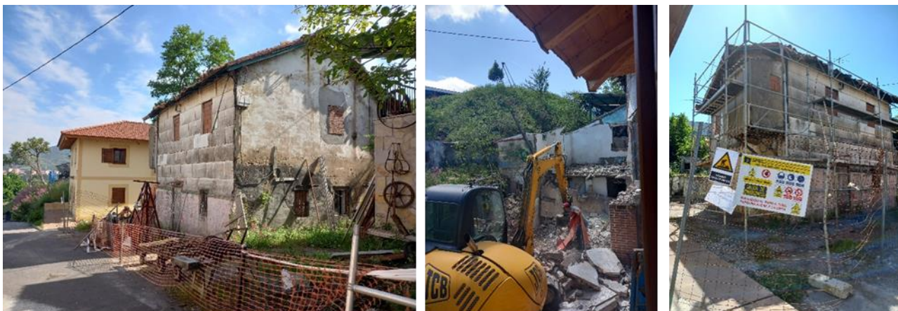
Imágenes del proceso de derribo
